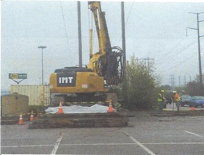
Fig 1: Crew finishing foundation pour on Str. E194-10
